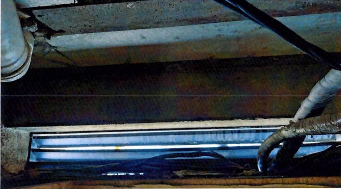
Figura 4: Grelha de exaustão existente montada sobre o banheiro que reside ao lado da área técnica.
